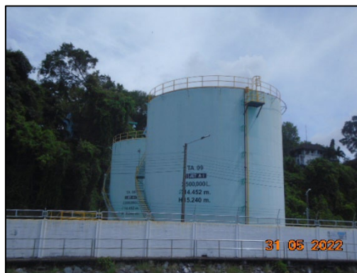
ภาพที่ 2-1 ถังเก็บน้ำมันสำรองประเภท Floating Roofs
